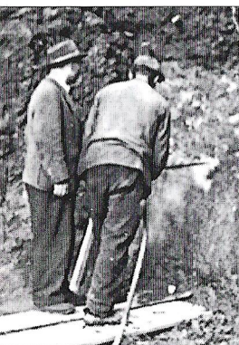
Le démarrage des travaux de percement du tunnel du Mt-Lachaux en 1942.
